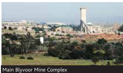
Main Blyvoor Mine Complex
